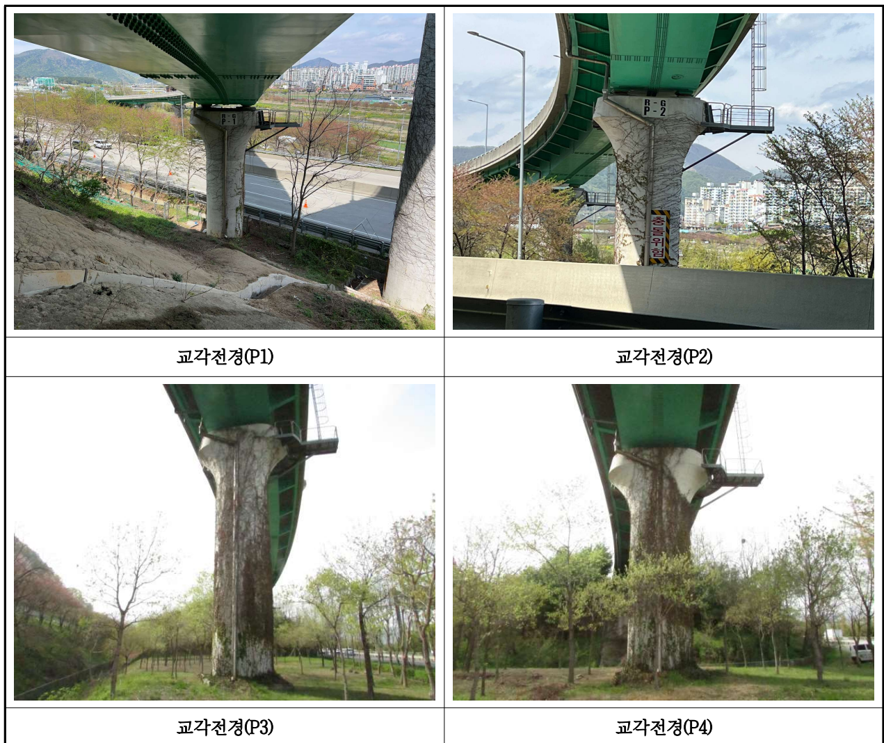
【사진 3.14】 교각 전경
