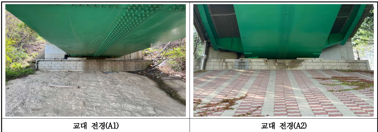
【사진 3.11】 교대 전경
