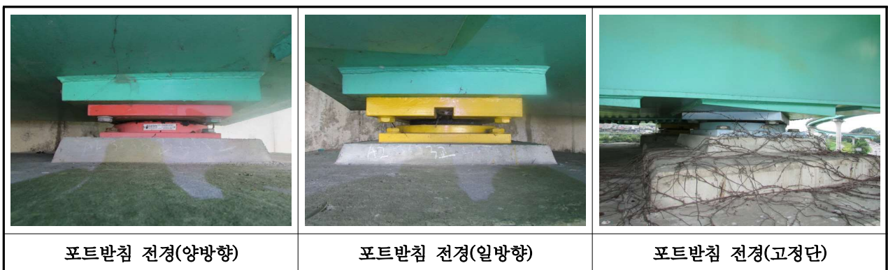
【사진 3.17】 교량받침 설치전경
