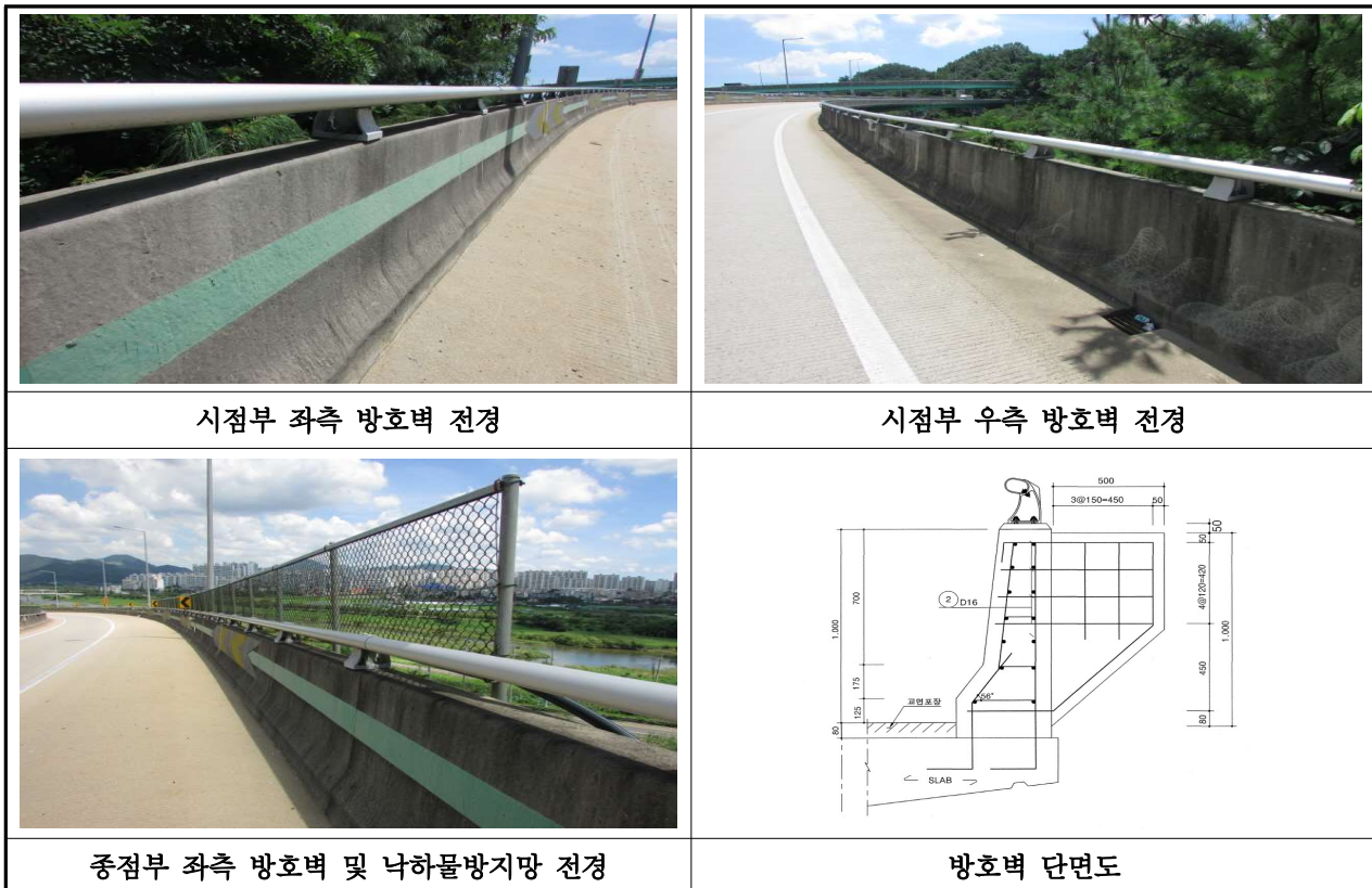
【사진 3.25】 난간 및 연석(방호벽) 전경
