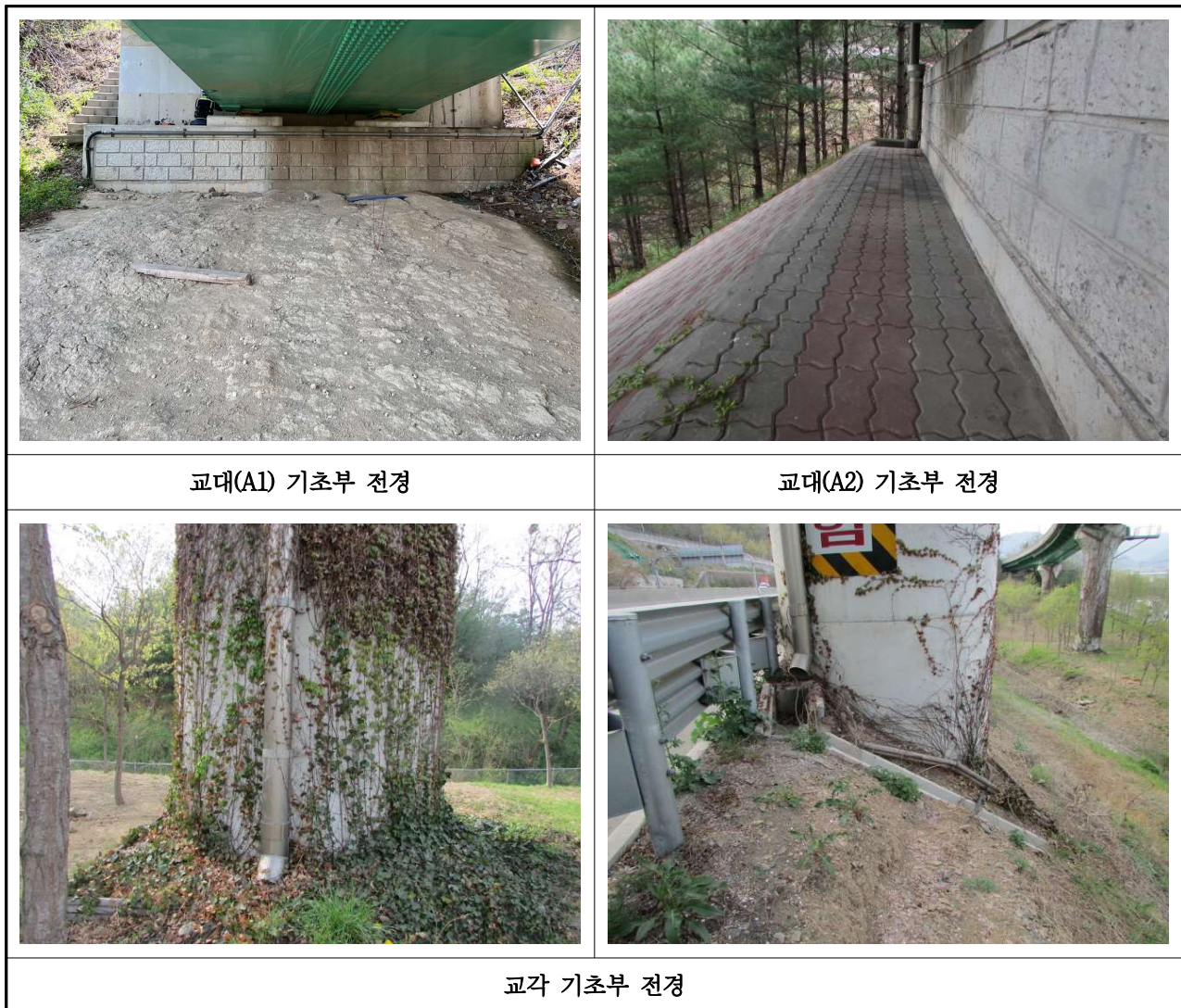
【사진 3.16】 기초부 외관조사 현황
